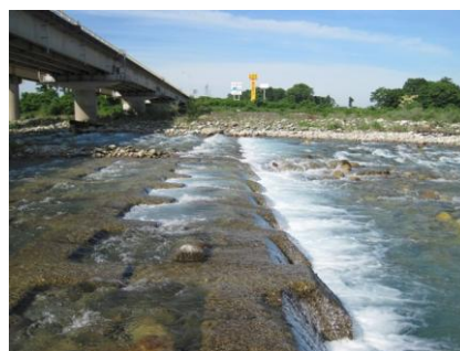
[定点2：県道135号線 早月大橋下]
