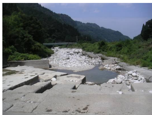
〔定点 4：第一発電所堰堤上・下〕
