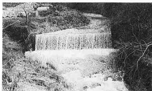
ダムから上流二つ目の堰堤で定点1のすぐ下流に位置する。高さ約2.5m 幅約13m
