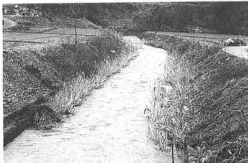
金山谷地内の湯橋から下流約200mまでの区間で、川幅は約8mで両岸はコンクリート護岸されているが、流れの縁にはヤナギ、ヨシなどの植物がはえている。河川形態は直線的になっており、中央部にある小さな堰堤の上流と下流にそれぞれ淵と瀬が一つずつある。最下流部は右に蛇行しており、流れが左岸にぶつかり大きい淵を形成している。
