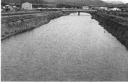
大光寺地内の住吉橋から上流約100mの区間で、川幅は約23mで両岸はコンクリート護岸されている。川の縁には砂や土が護岸から0.5～1mの幅で堆積しており、ヨシなどの植物がはえている。河川形態はほぼ直線的で、水深は平常時で約50cmくらいの瀬となっている。川底には時期によって一部にエビモ、バイカモが見られる。
